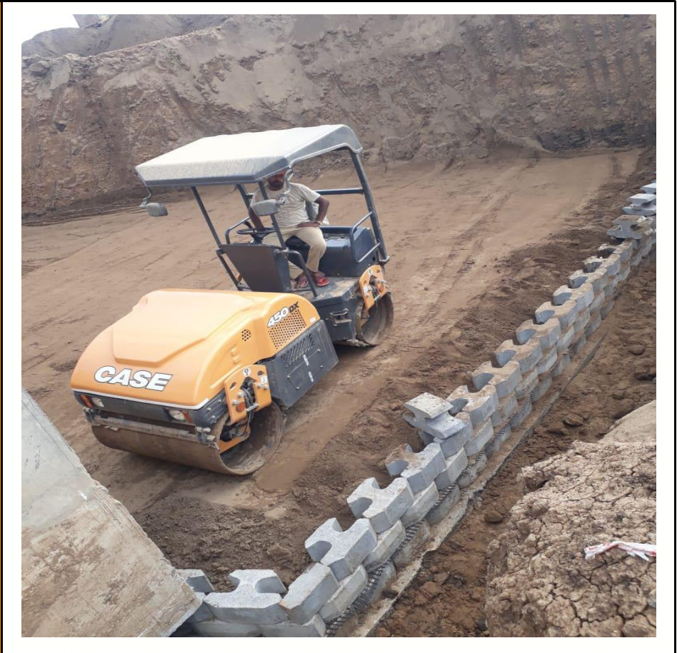
CH 313+061 RE WALL
