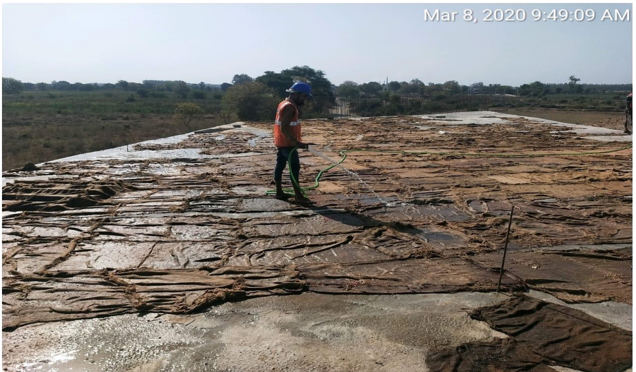
Dt. 08.03.2020 Ch-321+673 rhs lvup top slab curing (w.p)
