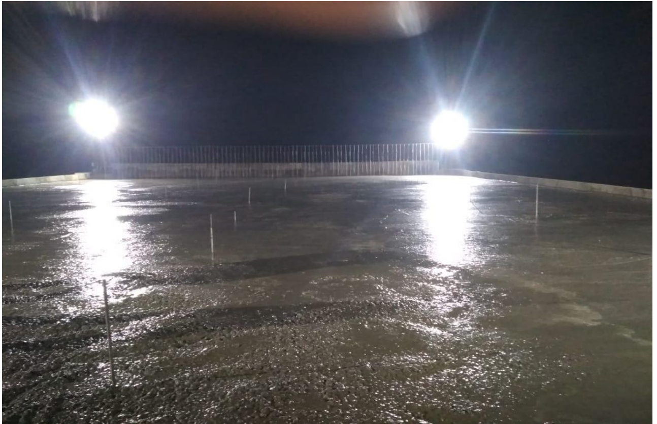
Dt. 08.03.2020 CH-300+725 pup slab rhs complete
