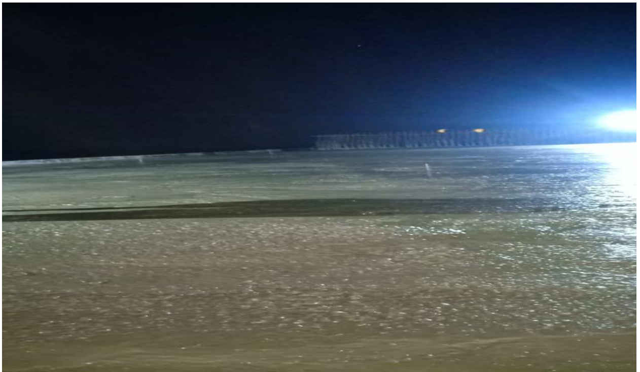
Dt. 09.03.2020 Ch 293+875 slab concrete complete
