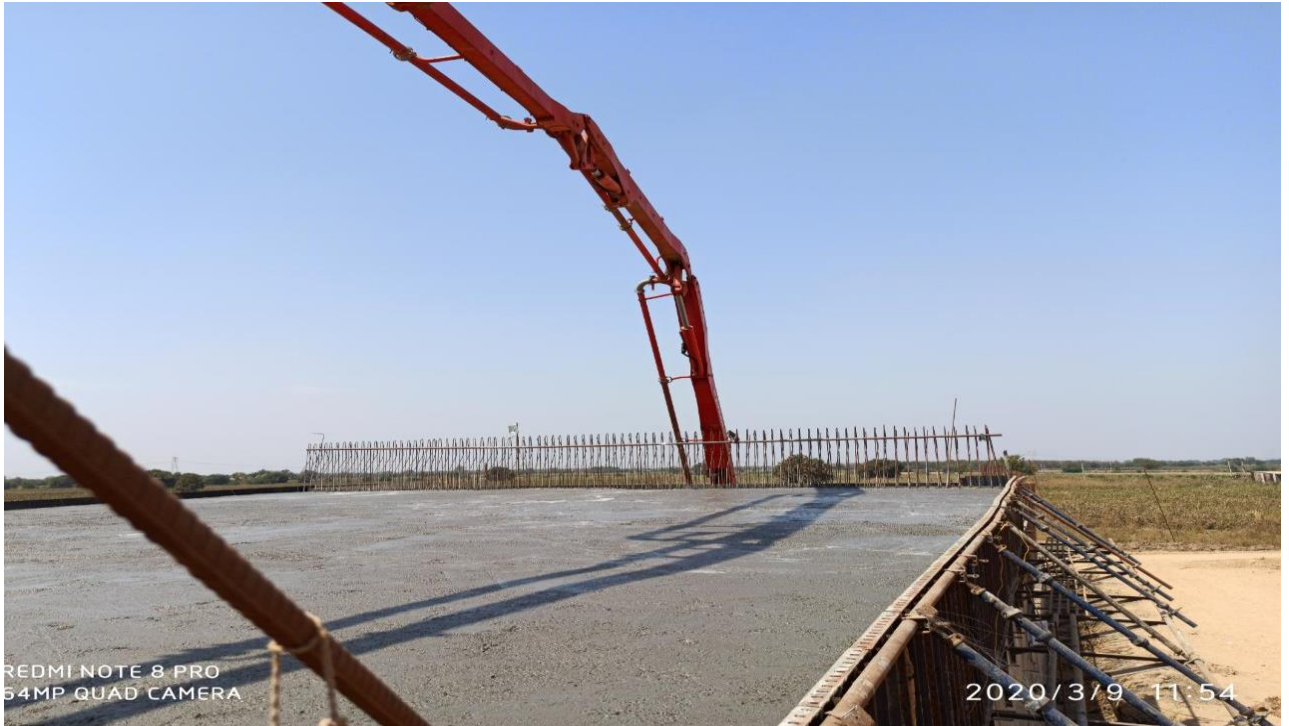
Dt. 09.03.2020 CH-314+850 pup RHS top slab pouring complete.
