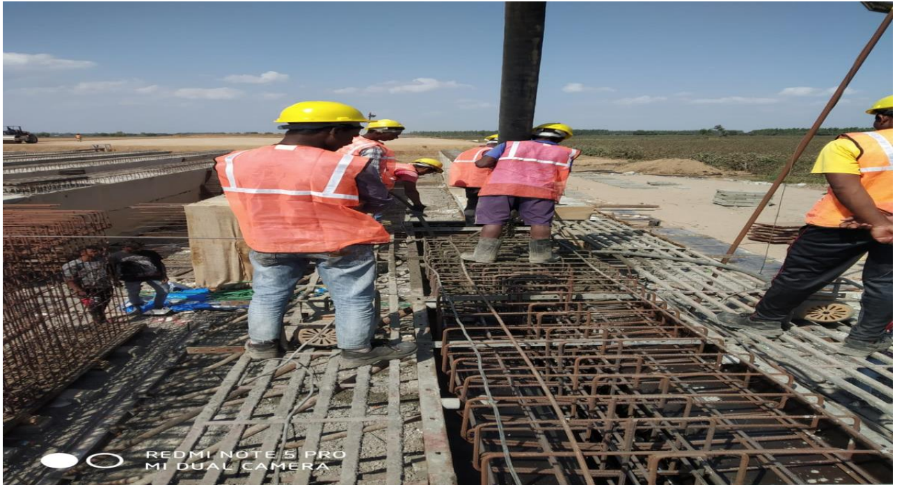
Dt. 11.03.2020 Concrete pouring in progress girder G1 RHS mjb CH-318+870
