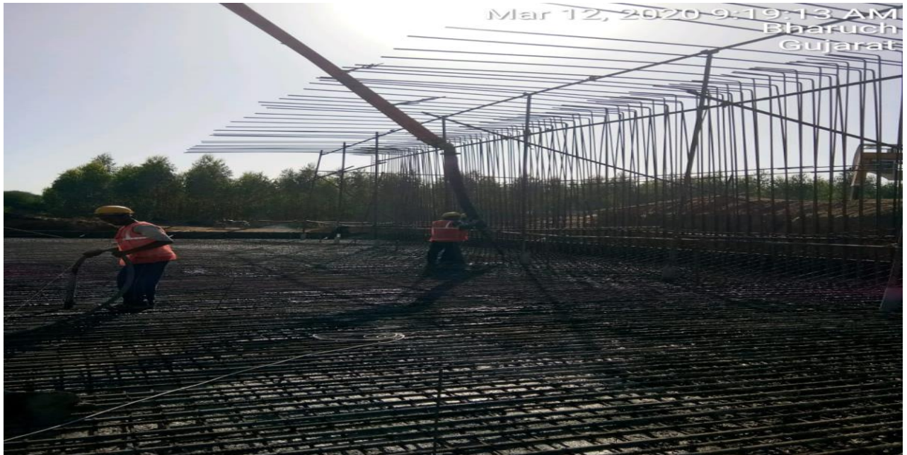
Dt. 12.03.2020 Chainage no 313+055 pup RHS raft.
