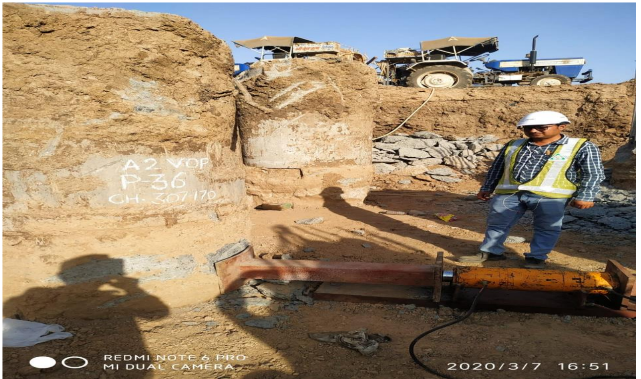
Dt. 07.03.2020 CH-307+170 VOP A2 ,RHS, pile no-36 Lateral pile load test in progress
