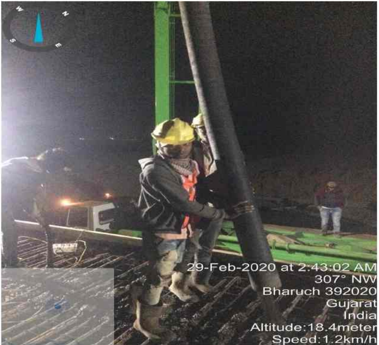
Ch 303+220 Rnstop slab pouring work start
