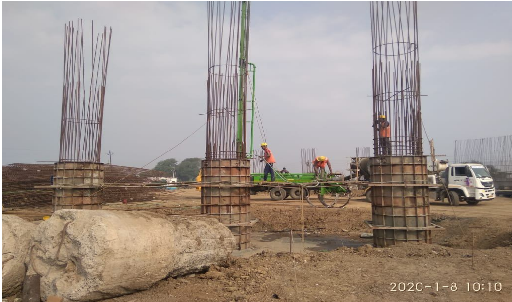
Dt. 08.01.2020 RP5 concreting 2 nd lift ROB
