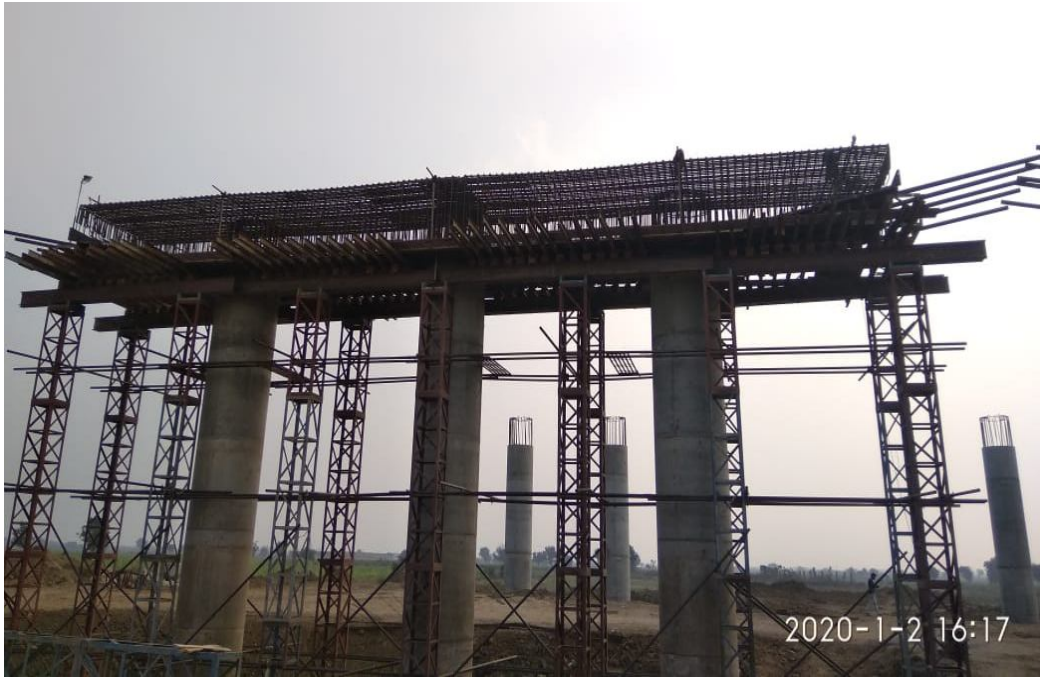
Dt. 02.01.2020 RP1 Pier cap reinforcement ROB
