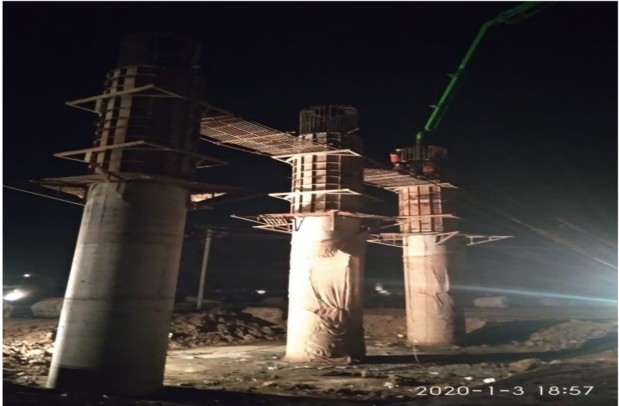
Dt. 03.01.2020 RP4 pier shaft 4 th lift ROB
