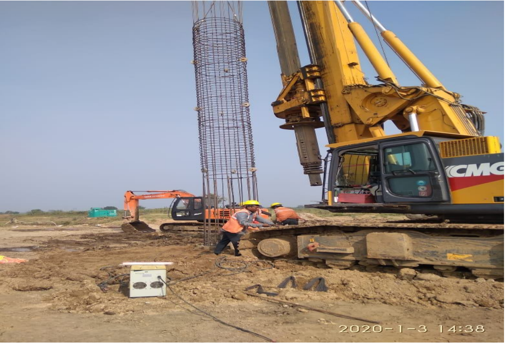
Dt. 03.01.2020 RP15 pile 387 Cage lowering ROB
