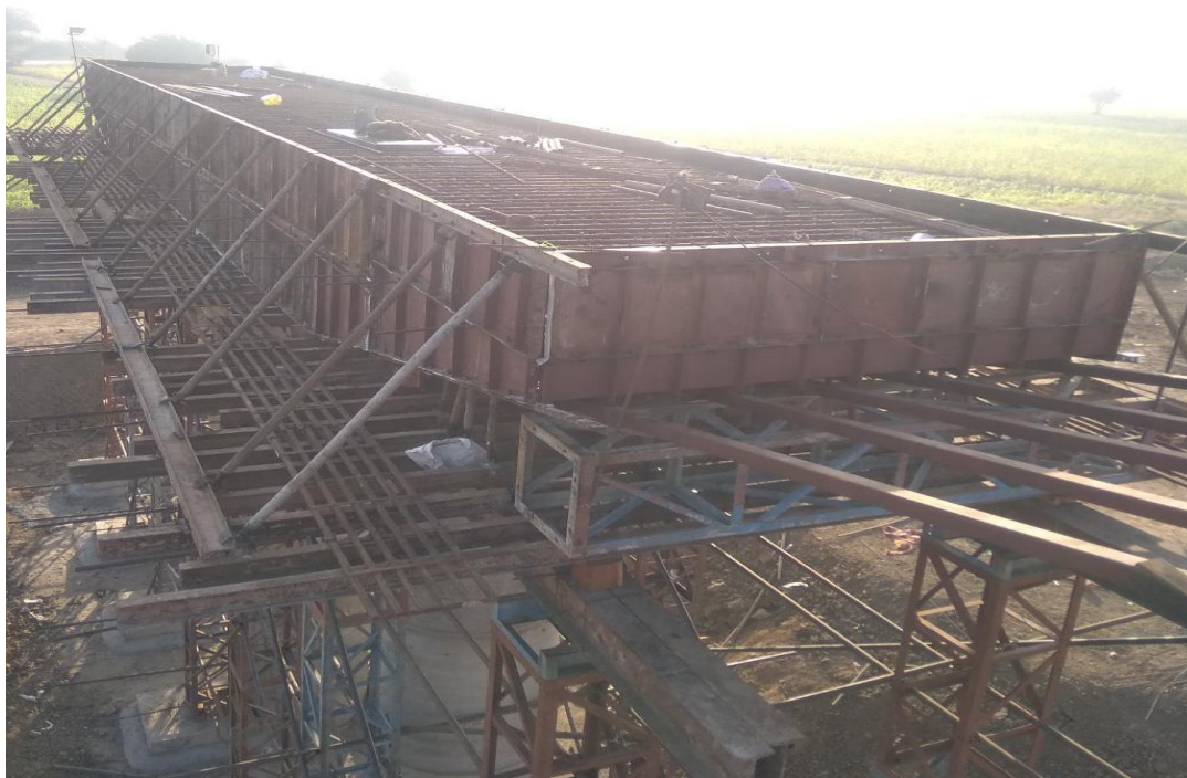
Dt. 09.01.2020 RP1 pier cap shuttering ROB
