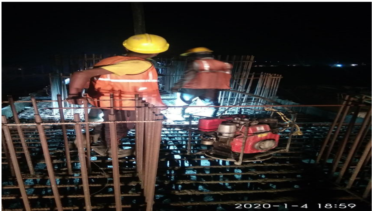
Dt. 04.01.2020 LP1 pier cap concreting ROB
