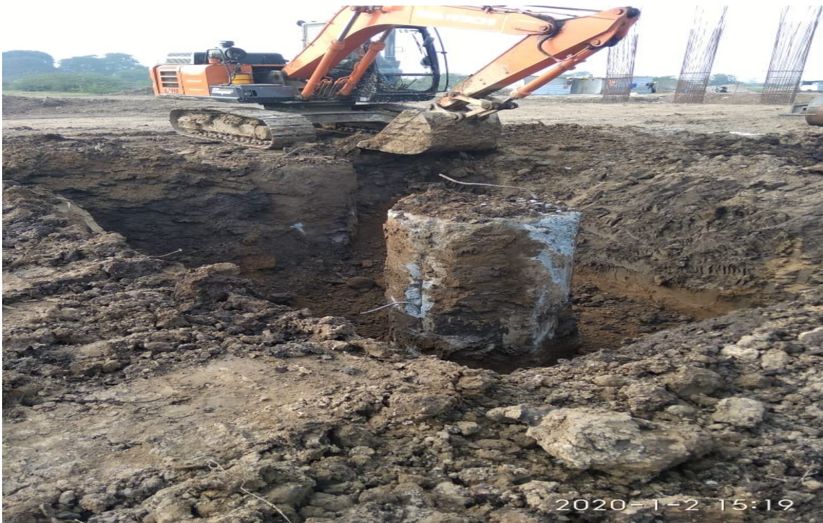
DT.02.01.2020 RP13 pile cap excavation start.
