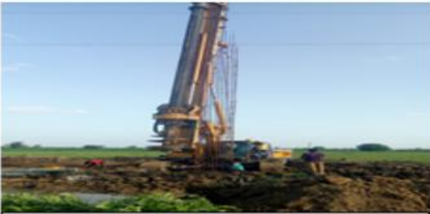
323+074 Pile no 8 RA 1 Cage Lowering
