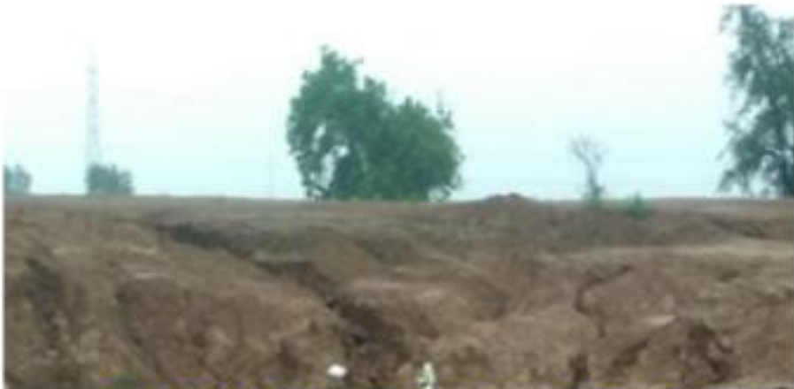
325+850 RAIN CUT DATE 08.08.2019
