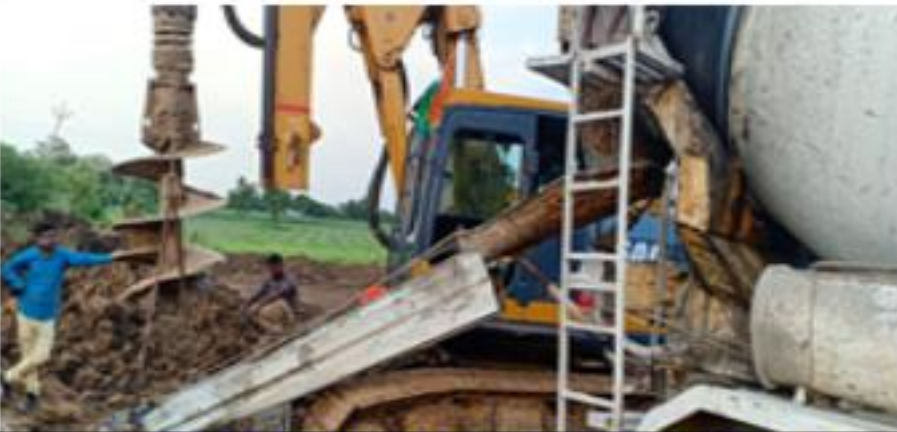
323+074 POURING START PILE NO 08 RA 1
