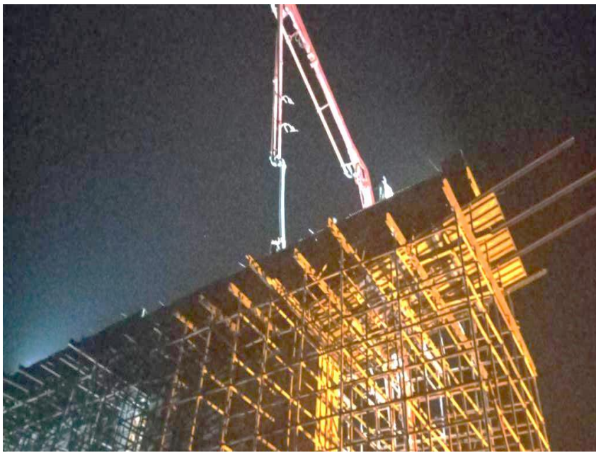
352+946 ROB RP1 Pier cap concrete pouring
