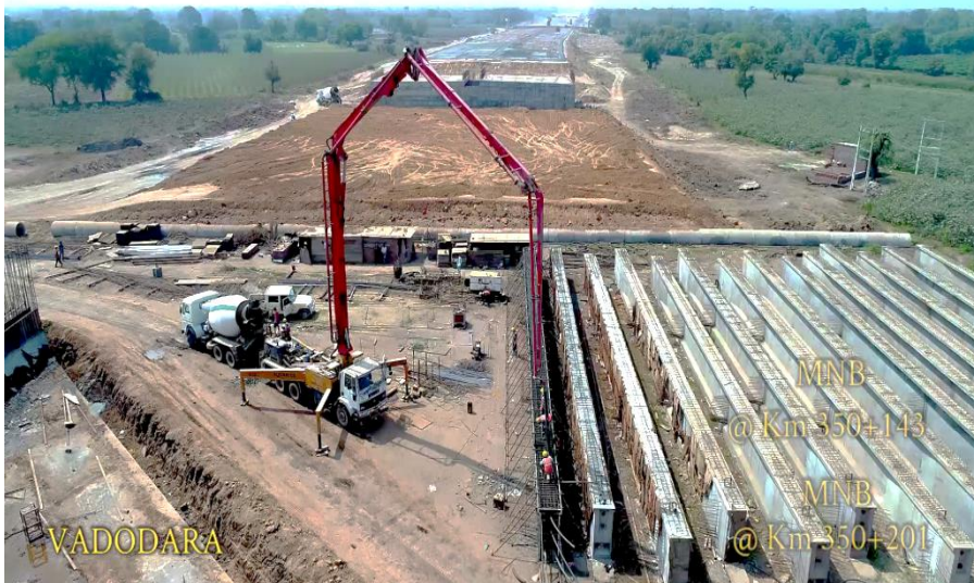
Girder Concrete Pouring 350+143 MNB
