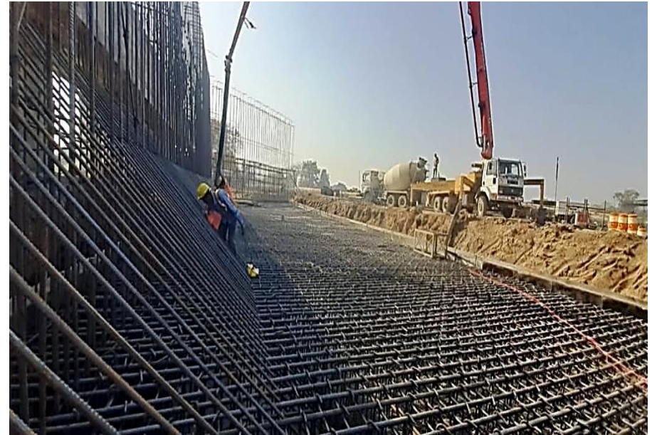
350+143 MNB Retaining wall Raft Concrete Pour
