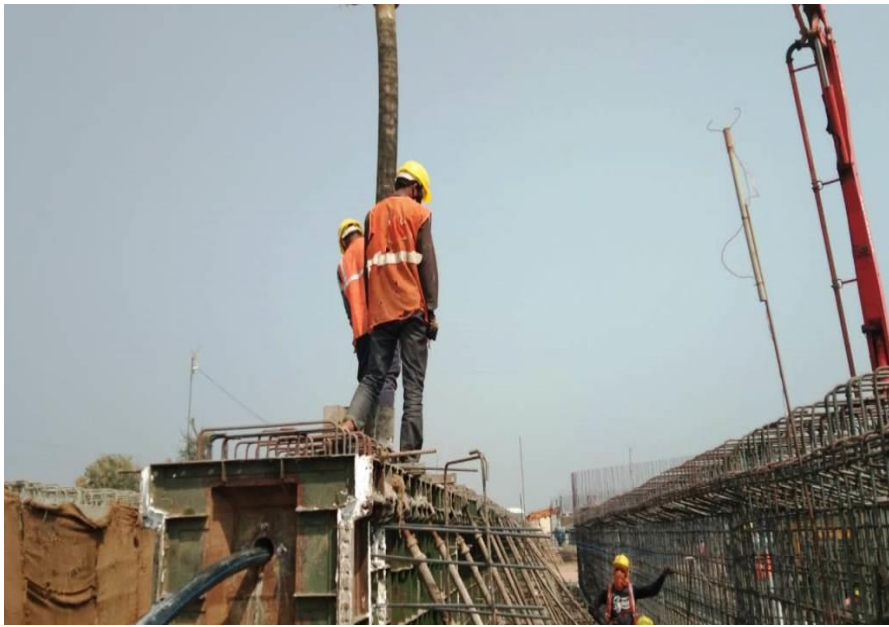
350+143 MNB Girder concrete pouring
