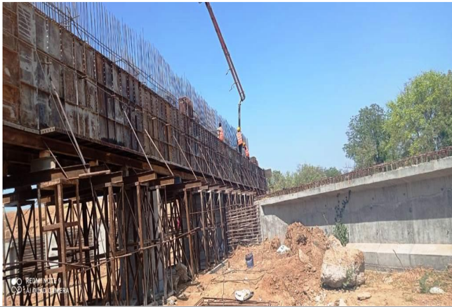
354+636 MNB A2 Segment 4 Abt. Cap concrete Pouring
