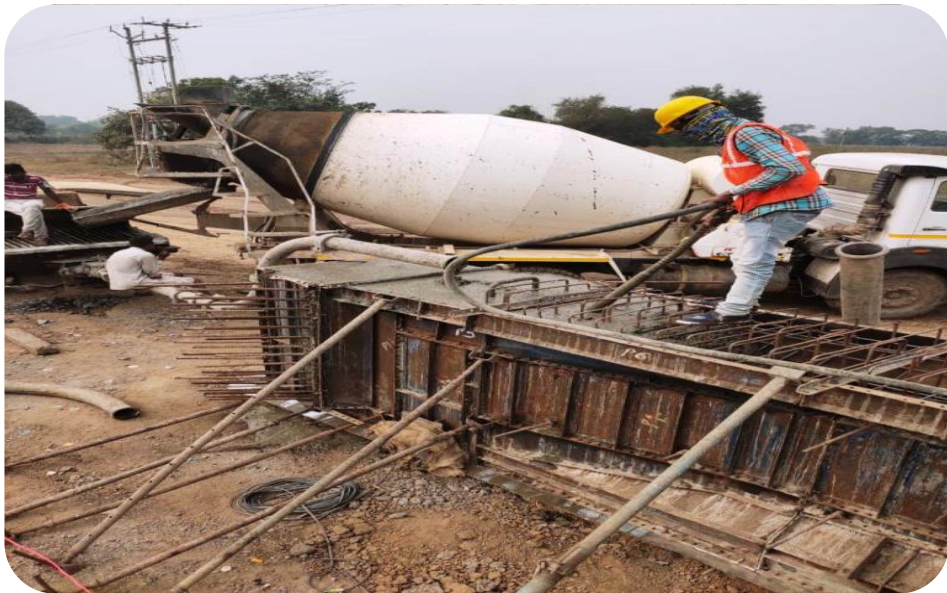
RCC GIRDER CONCRETE POURING @344+383
