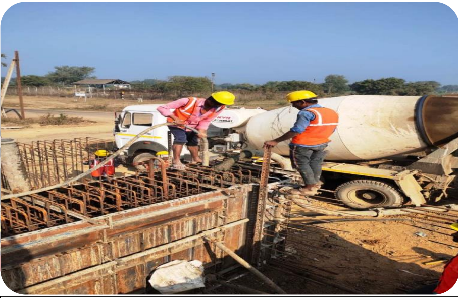
343+566 MNB PSC girder concrete pouring
