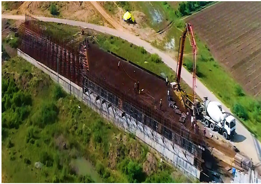
348+460 CUP Slab Concrete Pouring
