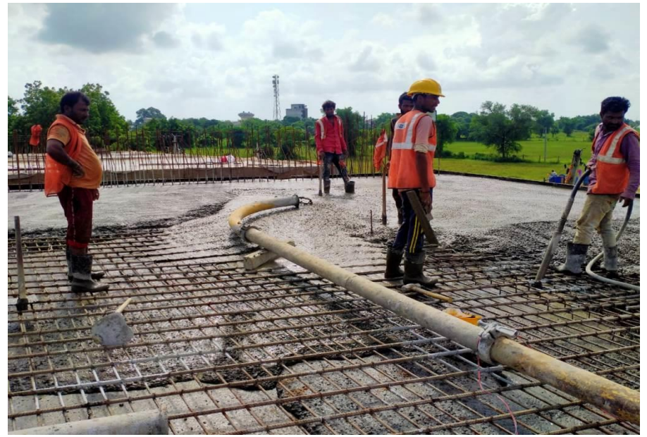
343+856 LHS Slab concrete pouring LVUP
