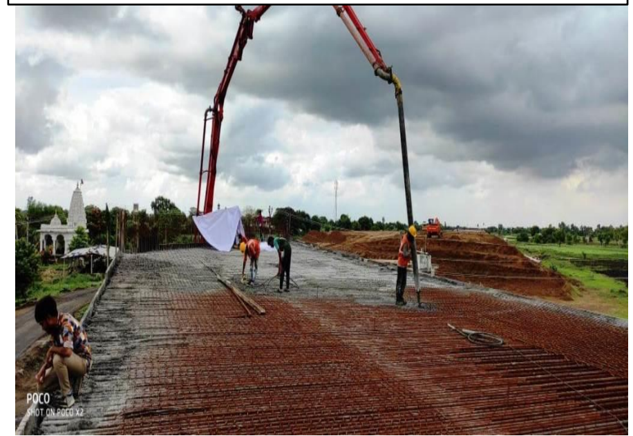
329+344 RHS SLAB CONCRETE POURING LVUP
