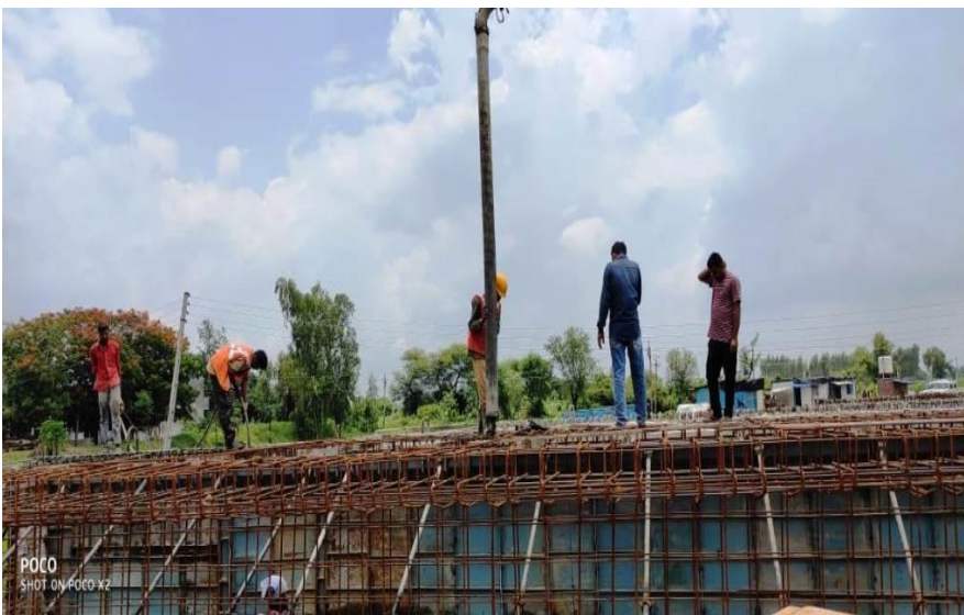
330+640 PSC GIRDER CONCRETE POURING MNB
