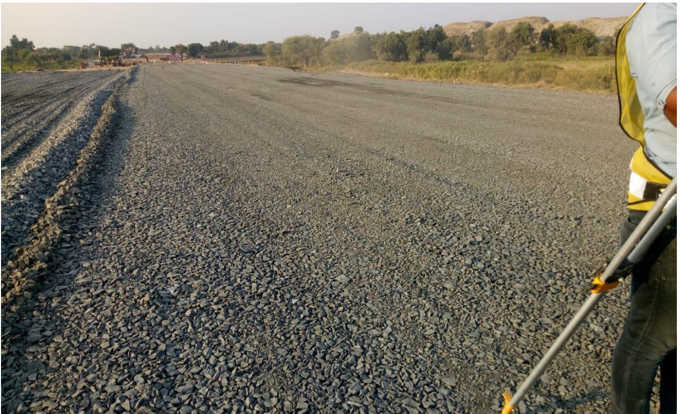
Granular Sub-Base Layer
