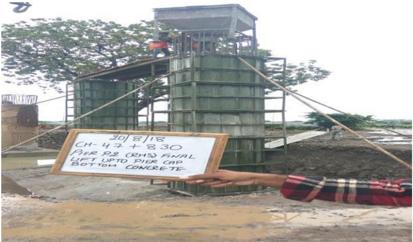
CH -47+ 830 PIER P2
