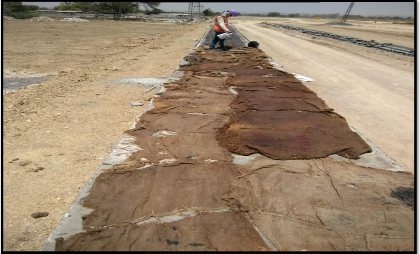
Drain Slab & Wall @ Ch 26+665 to 26+690
