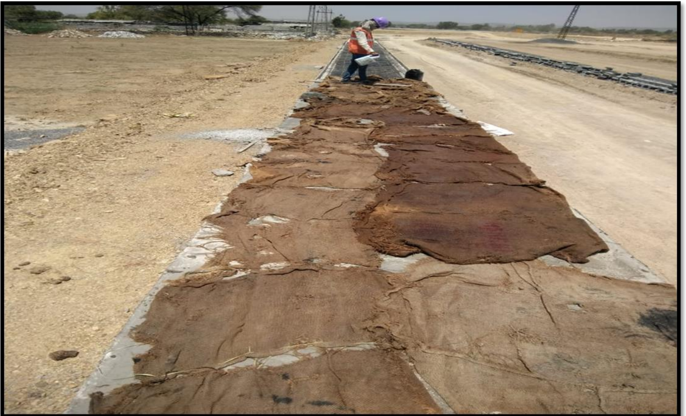
Drain Slab & Wall @ Ch 26+665 to 26+690
