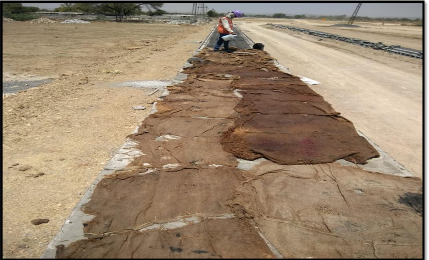
Drain Slab & Wall @ Ch 26+665 to 26+690
